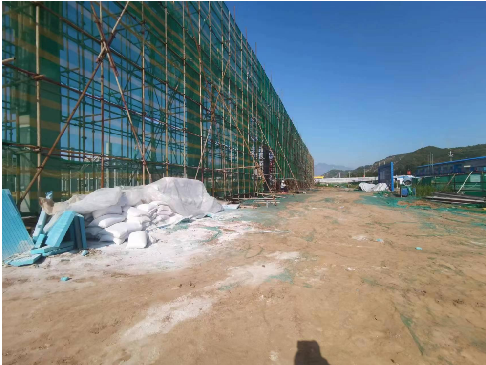
照片 1 建构筑物区
