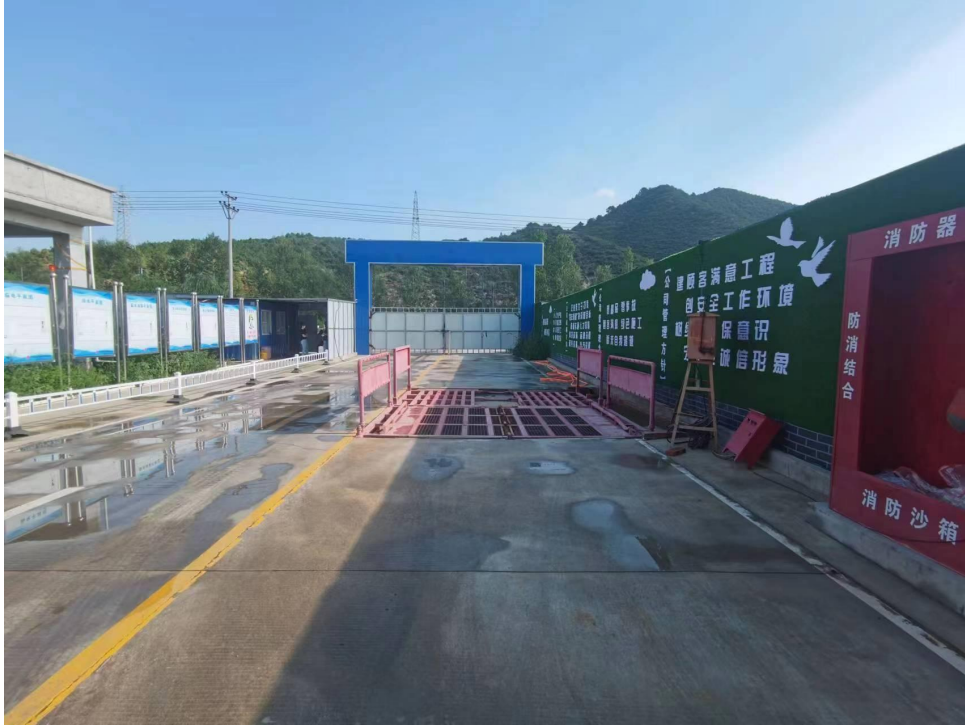
照片 2 项目区出入口
